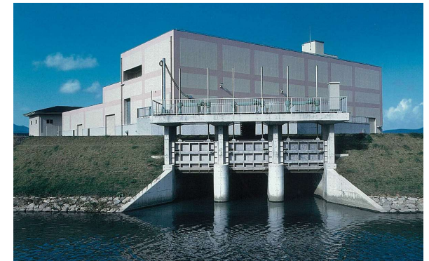
▲ 雨水排水機場/下川原雨水ポンプ場
